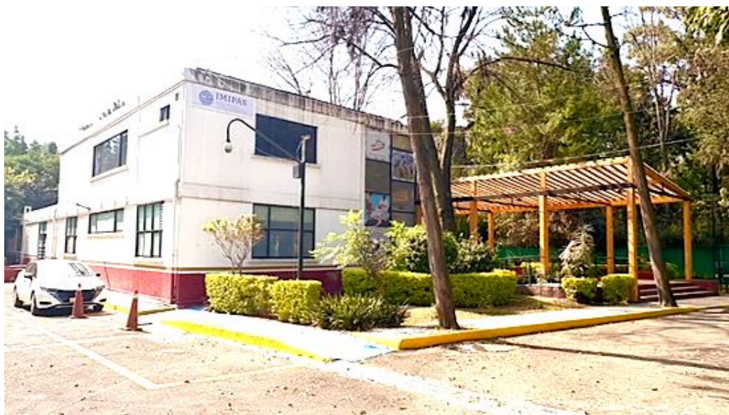
Imagen 3. Panorámica de oficinas centrales del IMIPAS en la CDMX.
