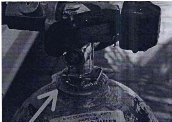
Figura 31. Detalle de la fuga que presentan 3 de los tanques que se intentó llenar.
