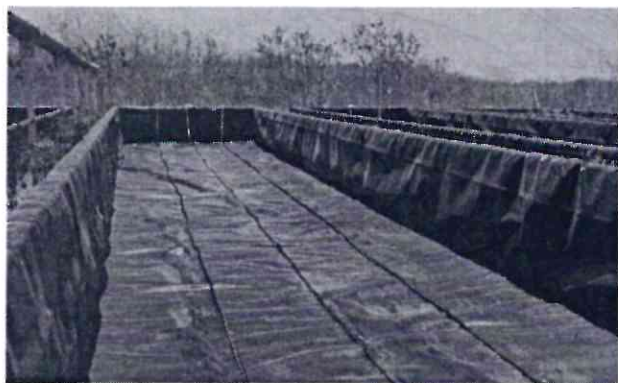
Figura 6. Estado general de los raceways y distribución de la aeración
