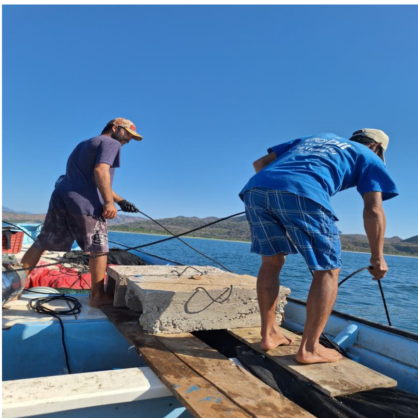
Traslado y vertimiento de los agregadores artificiales “Casitas Cubanas” en la zona marina frente a las playas de río Nexpa, Caleta de Campos, Michoacán.
