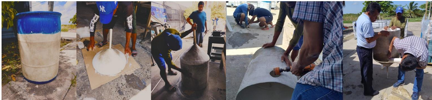
Fabricación del hidrociclón, con material de fibra de vidrio y PVC.
