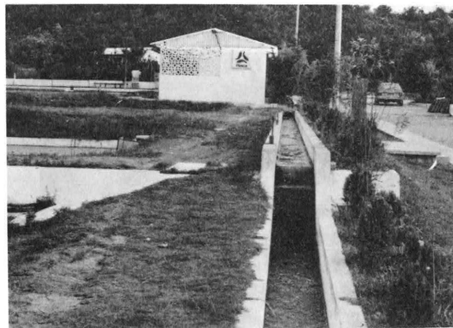
Fig. 6. Canal de conducción de cemento, obsérvese la doble caída que ayuda al agua a aumentar su contenido de oxígeno.
