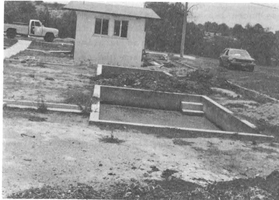
Fig. 42 Estiércol de cerdo en un tanque de fermentación de cemento.
