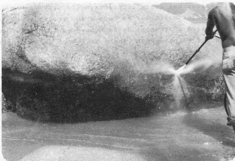
Figura 7 - Vista da limpeza parcial de uma pedra através do processo de alta pressão.
