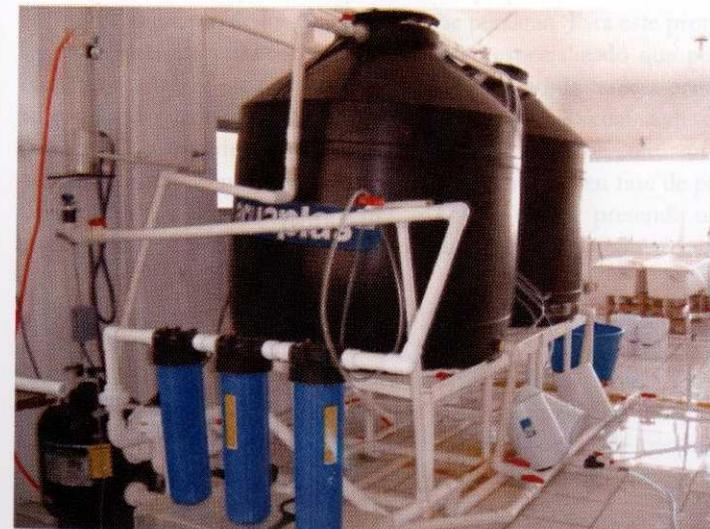
Figura 17. Sistema de filtración y esterilización de agua marina que se instaló en el CRIP Puerto Morelos del INP.
